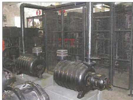
Bild 8: Gebläse zur Funkenlöschung
