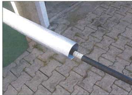
Bild 7: Vorbereitung der Außenleiterkontaktierung; das 1/2-Zoll-Kabel ist am unteren Mastende abzuisolieren.
