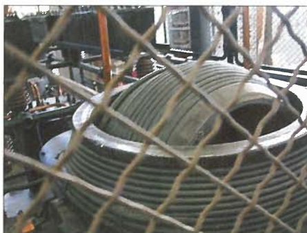
Bild 9: Antennenvariometer im Gitterkäfig
