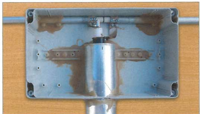
Bild 2: Dipolanschlusskasten mit zwei Aluminiumrohren am Anfang der Dipolhälften und eingeklebtem, 8 mm dicken Glasfiberrundstab
