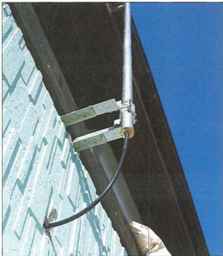
Bild 6: Unteres Mastende am Balkon mit fertig montiertem Kurzschlussstück gemäß Bild 4 und Koaxialkabel-Durchführung
