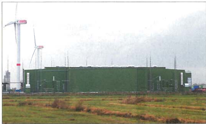
Bild 1: Stromrichterhalle für die neue Hochspannungs-Gleichstrom-Übertragungsanlage HelWin1; am rechten und linken Rand der Halle sind die beiden Gleichstromschaltanlagen zu sehen.
